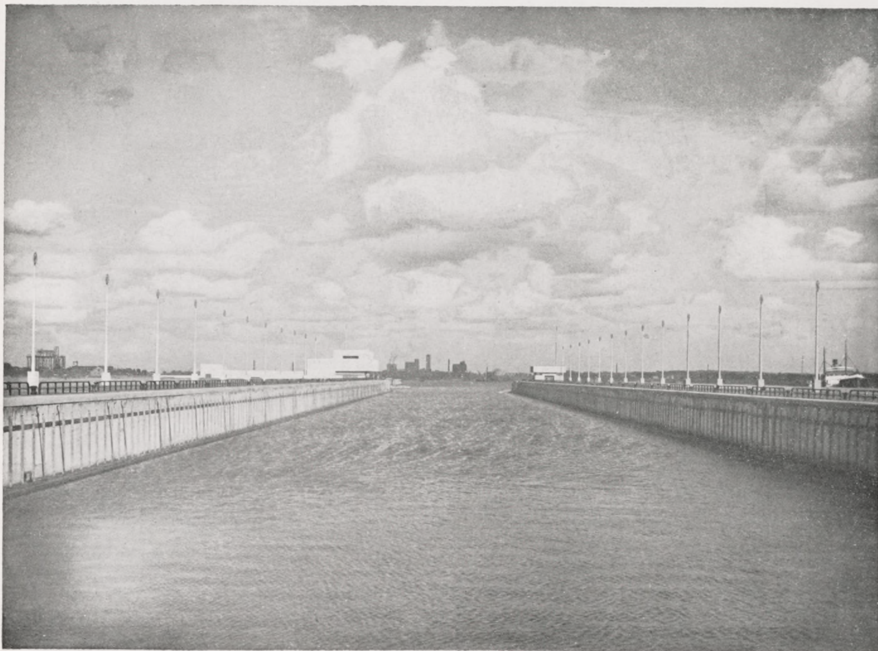
127. Le nouveau chenal de l'écluse d'Ijmuiden.
