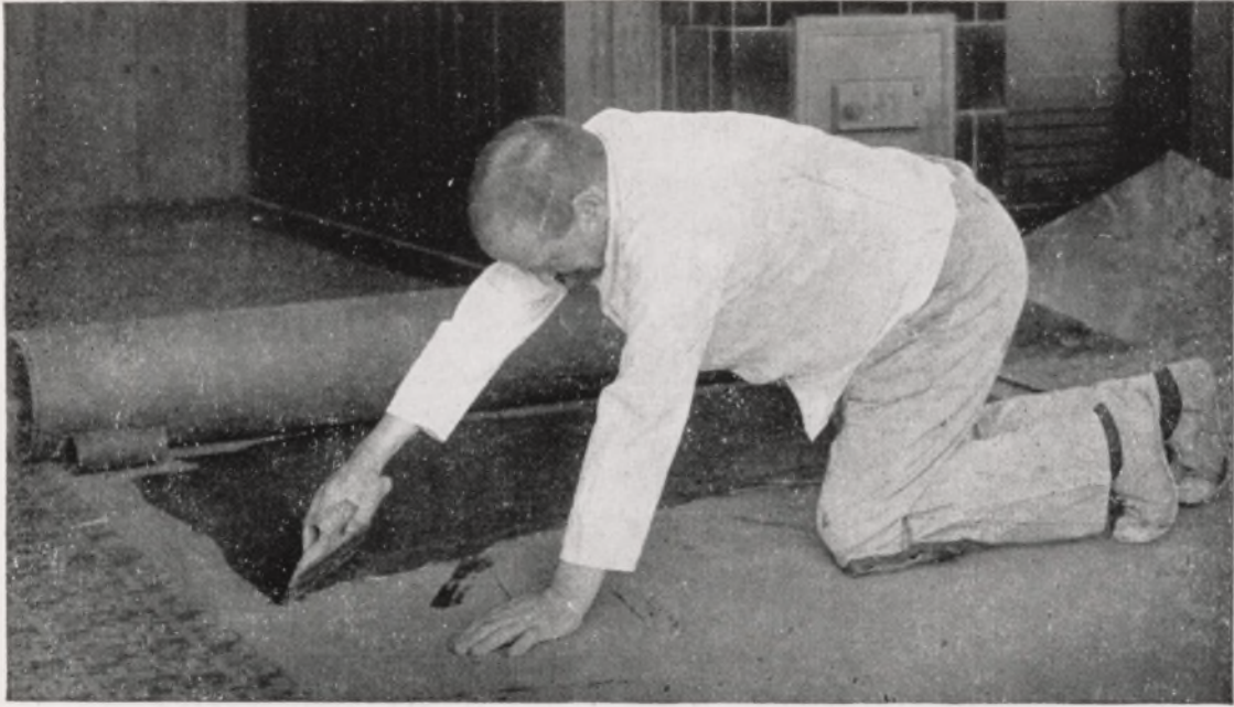
138. Encollage d'un plancher.
